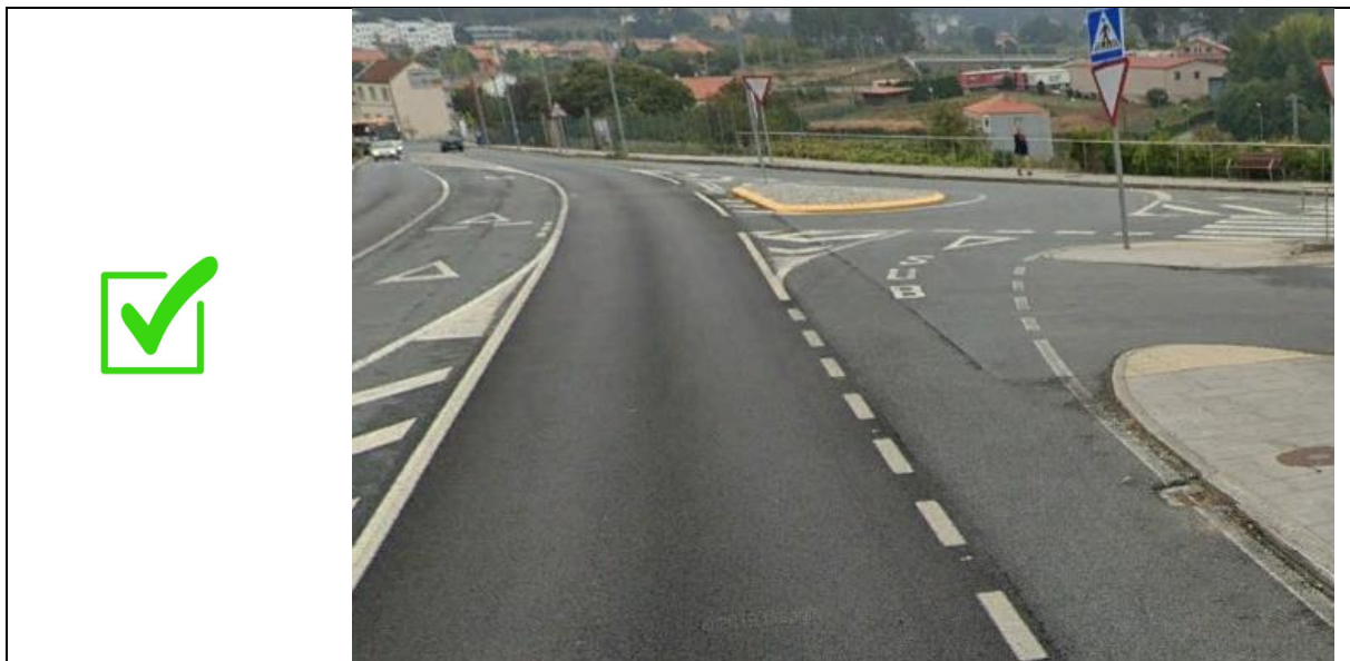
Mellora recente da localización dunha parada de autobús no carril de desaceleración dunha intersección
