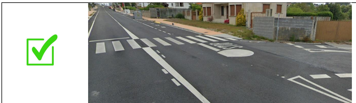
Mellora recente da localización dunha parada de autobús no carril de aceleración dunha intersección e situada despois dun paso peonil
